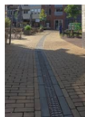
voorbeeld gidslijn in de vorm van lijngoot
