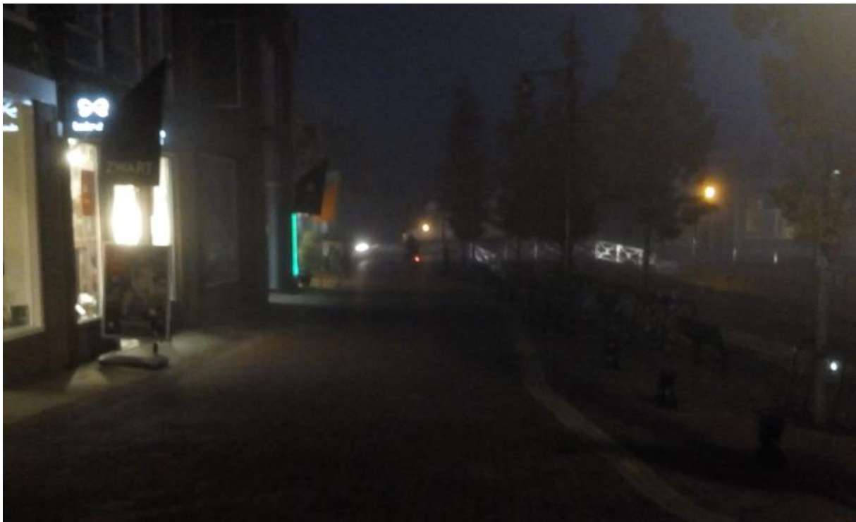
Niet werkende verlichting in het centrum van Dokkum.
